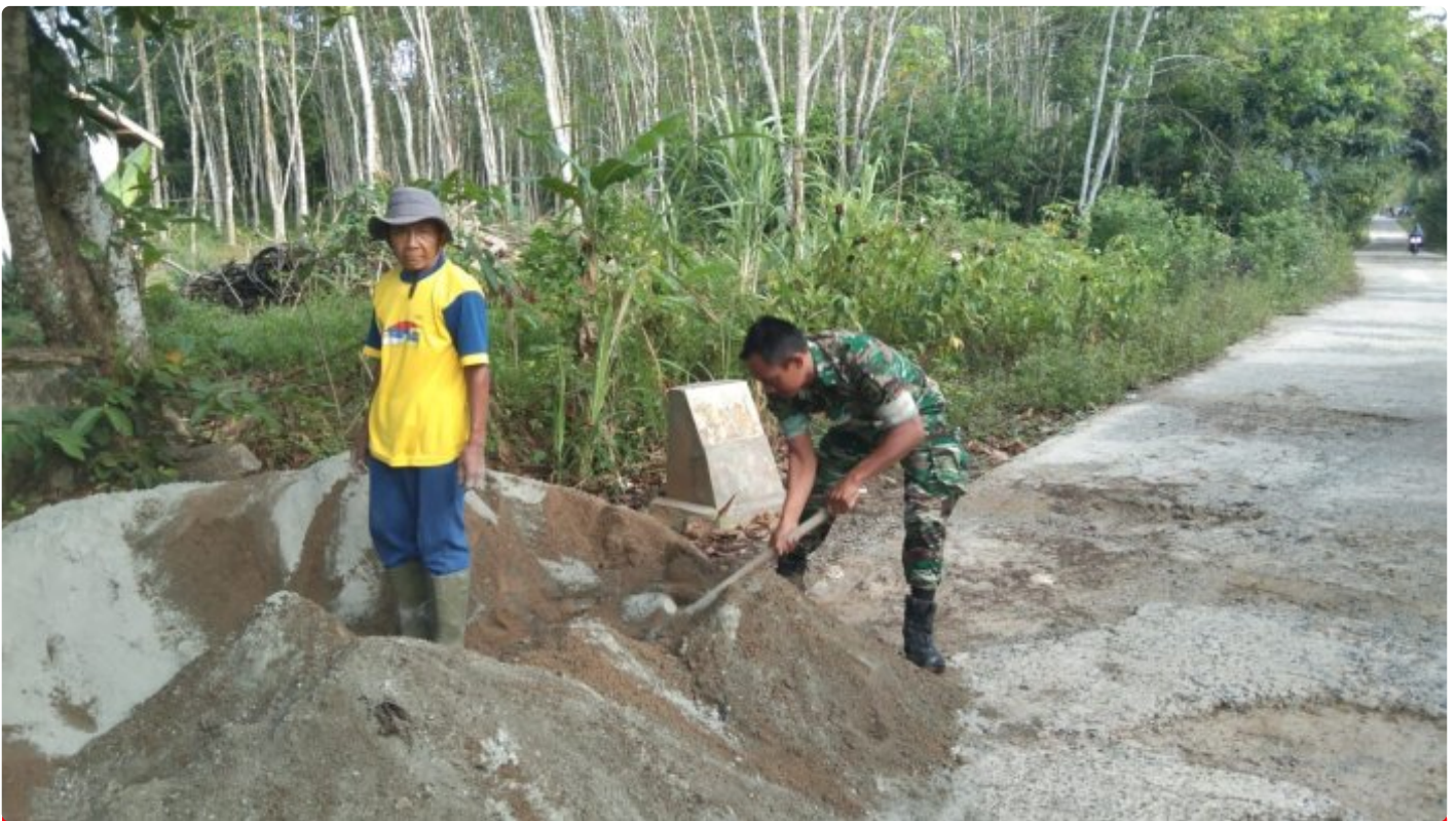
Babinsa Bantu Gotong Royong Pengecoran Jalan
